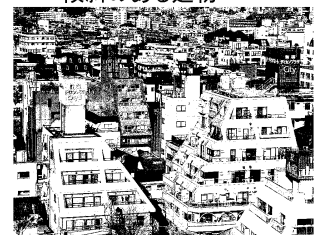
傾斜のある建物
