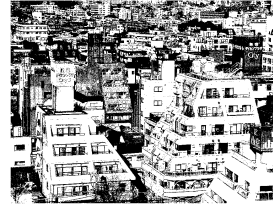
傾斜のある建物
