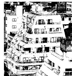
右の資料は、建築基準法の規制によって上階に行くほど建物がせまくなっているが、このような建て方の規制が行われているのは、近隣の住民の( ④ )権という(②)権を守るためである。
